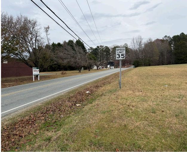
Looking E along UIT Rd
